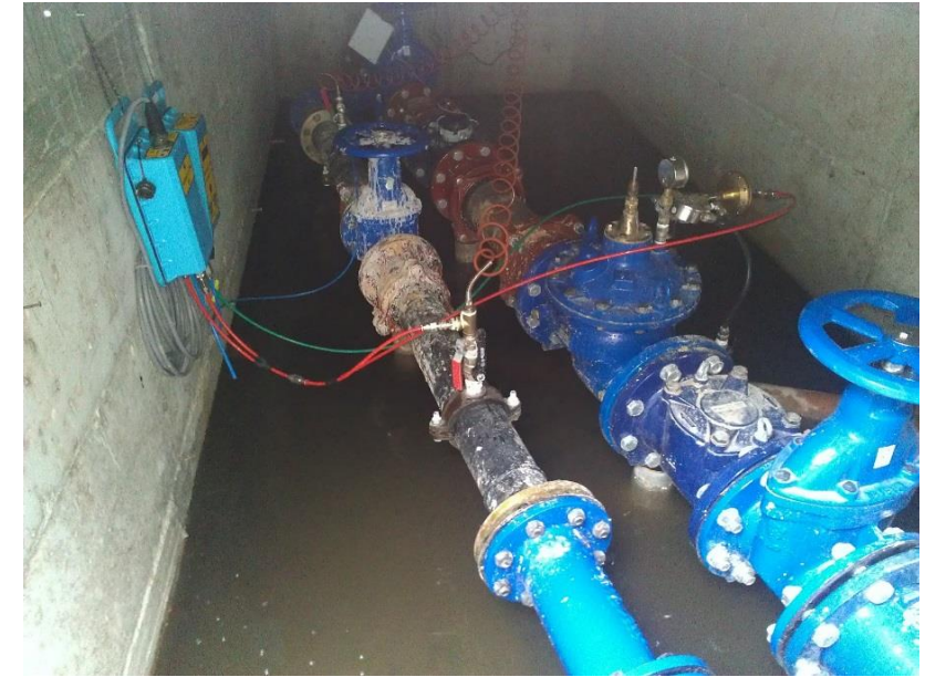
Οι διατάξεις που τοποθετήθηκαν στις πιλοτικές DMAs
